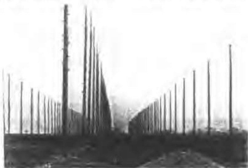
图 12.4 位于英国的一部 49 个单元宽为 300m 的收-发可控天线阵列的照片
