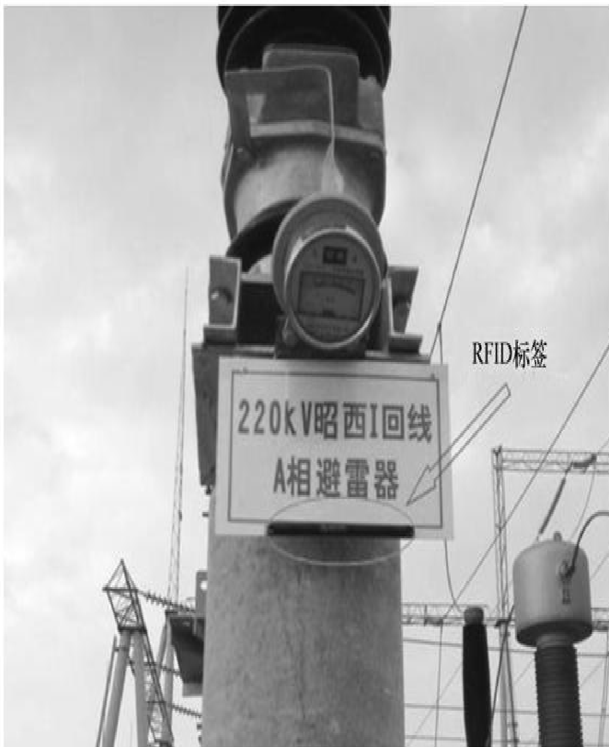
图4-3 RFID标签粘贴
