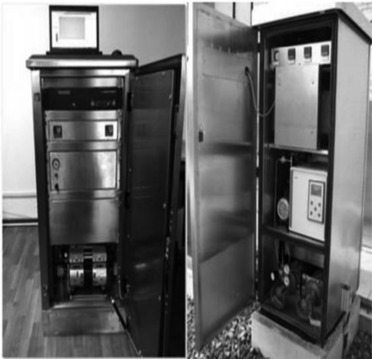
图2-80 变压器一体化智能监测装置图
