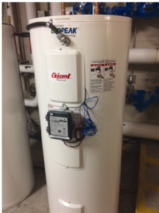
图11-15 与FAN需求响应控制器相连的电热水器
