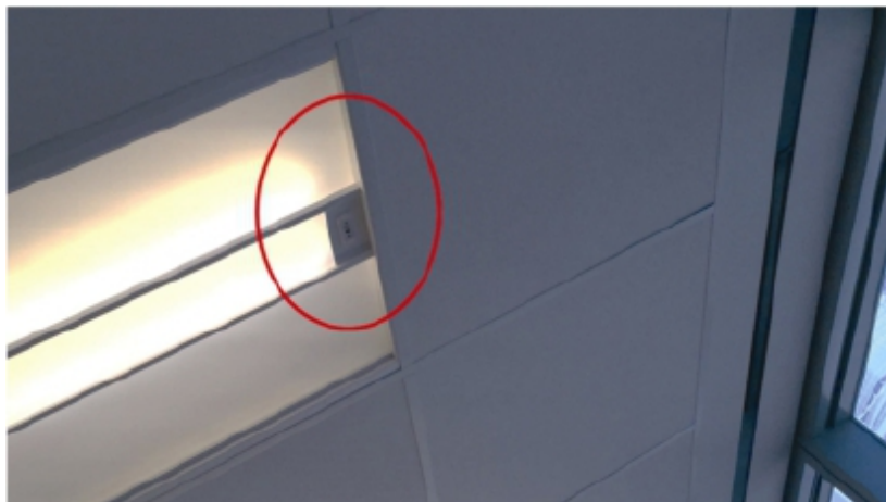
图1-9 一个携带住户传感器的LED数字天花板照明灯
