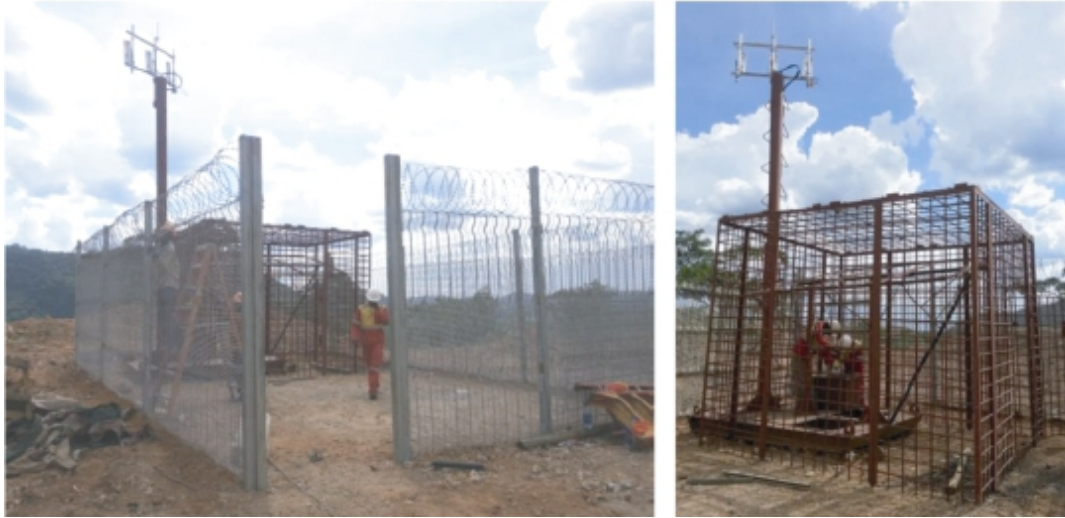
图14-12 矿山现场无线网状网络设备的物理安全防护
